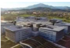
1. Azienda Ospedaliera Ospedali Riuniti di Bergamo Nuovo Ospedale di Bergamo "Papa Giovanni XXIII" (Arch. Zublena) Importo lavori: € 237.480.241,92
