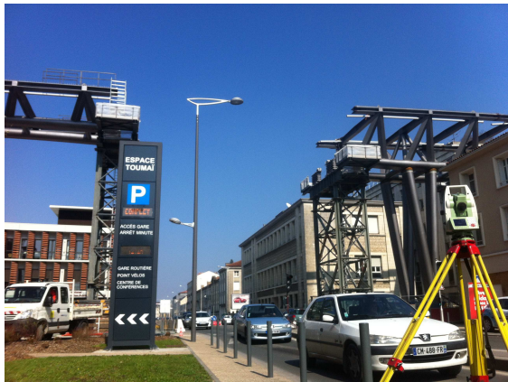
Viaduc Des Rocs (Viaduc Léon-Blum) a Poitiers (F), il viadotto, lungo 330 m e largo 15 m., è composto da 4 campate di circa 80 m. cadauna. Il ponte collega il centro della città con il quartiere occidentale ed attraversa la valle creando un'interconnessione tra la stazione ferroviaria sulla linea Parigi-Bordeaux ed il piano superiore del parcheggio multinodale.
