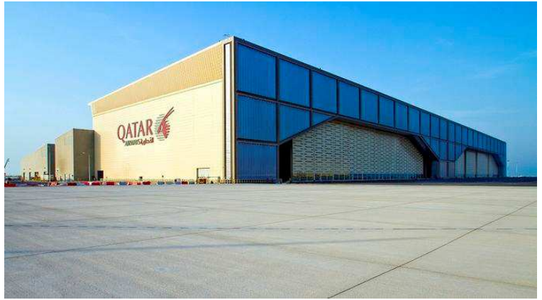
Doha International Airport Aircraft Maintenance Hangar Facility in Qatar. Composto da 2 Hangar, il primo di luce netta 220m ed il secondo più piccolo di m. 180, per la costruzione si sono utilizzate 24000 tonnellate di acciaio strutturale
