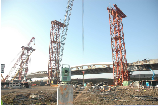
Ponte strallato di scavalco dell'Autostrada A1 e della Linea AV a Reggio Emilia progettato dall'Arch. Santiago Calatrava – campata m. 220, altezza arco m. 50
