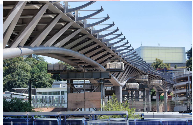
Viaduc Des Rocs (Viaduc Léon-Blum) a Poitiers (F), il viadotto, lungo 330 m e largo 15 m., è composto da 4 campate di circa 80 m. cadauna. Il ponte collega il centro della città con il quartiere occidentale ed attraversa la valle creando un'interconnessione tra la stazione ferroviaria sulla linea Parigi-Bordeaux ed il piano superiore del parcheggio multinodale.
