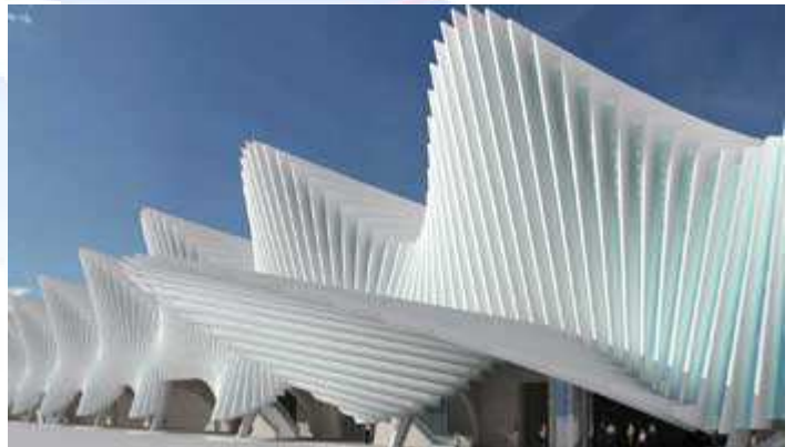
Stazione Ferroviaria AV Mediopadana Reggio Emilia – Struttura progettata dall'architetto spagnolo Santiago Calatrava è caratterizzata da un lungo design futuristico che prevede la ripetizione, venticinque volte, di un modulo di 25,40 m. di tredici differenti portali in acciaio di altezza media 20 m.
