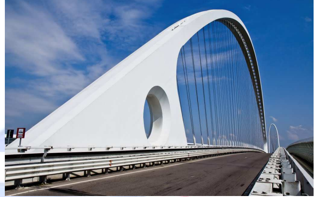
Ponte strallato di scavalco dell'Autostrada A1 e della Linea AV a Reggio Emilia progettato dall'Arch. Santiago Calatrava – campata m. 220, altezza arco m. 50
