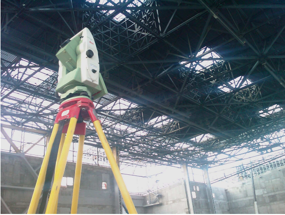
Doha International Airport Aircraft Maintenance Hangar Facility in Qatar. Composto da 2 Hangar, il primo di luce netta 220m ed il secondo più piccolo di m. 180, per la costruzione si sono utilizzate 24000 tonnellate di acciaio strutturale
