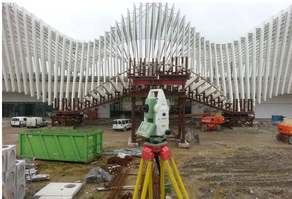
Stazione Ferroviaria AV Mediopadana Reggio Emilia – Struttura progettata dall'architetto spagnolo Santiago Calatrava è caratterizzata da un lungo design futuristico che prevede la ripetizione, venticinque volte, di un modulo di 25,40 m. di tredici differenti portali in acciaio di altezza media 20 m.
