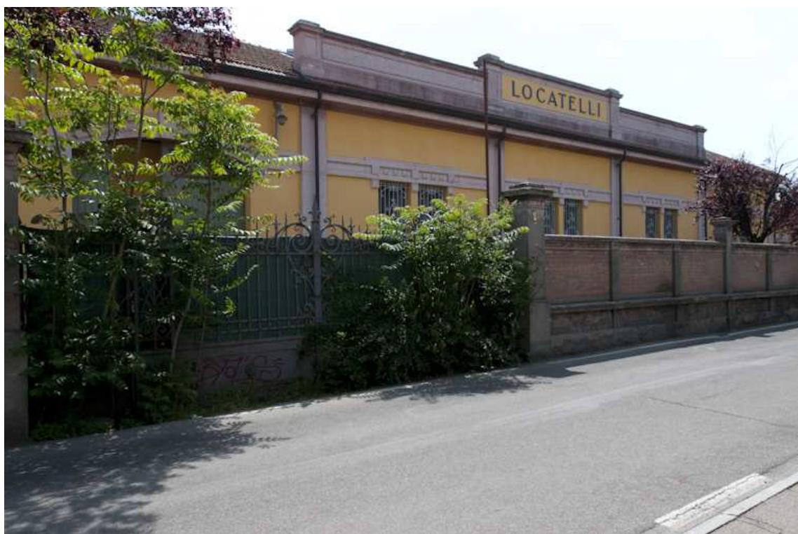
Vista del fronte del complesso storico su via Bligny
