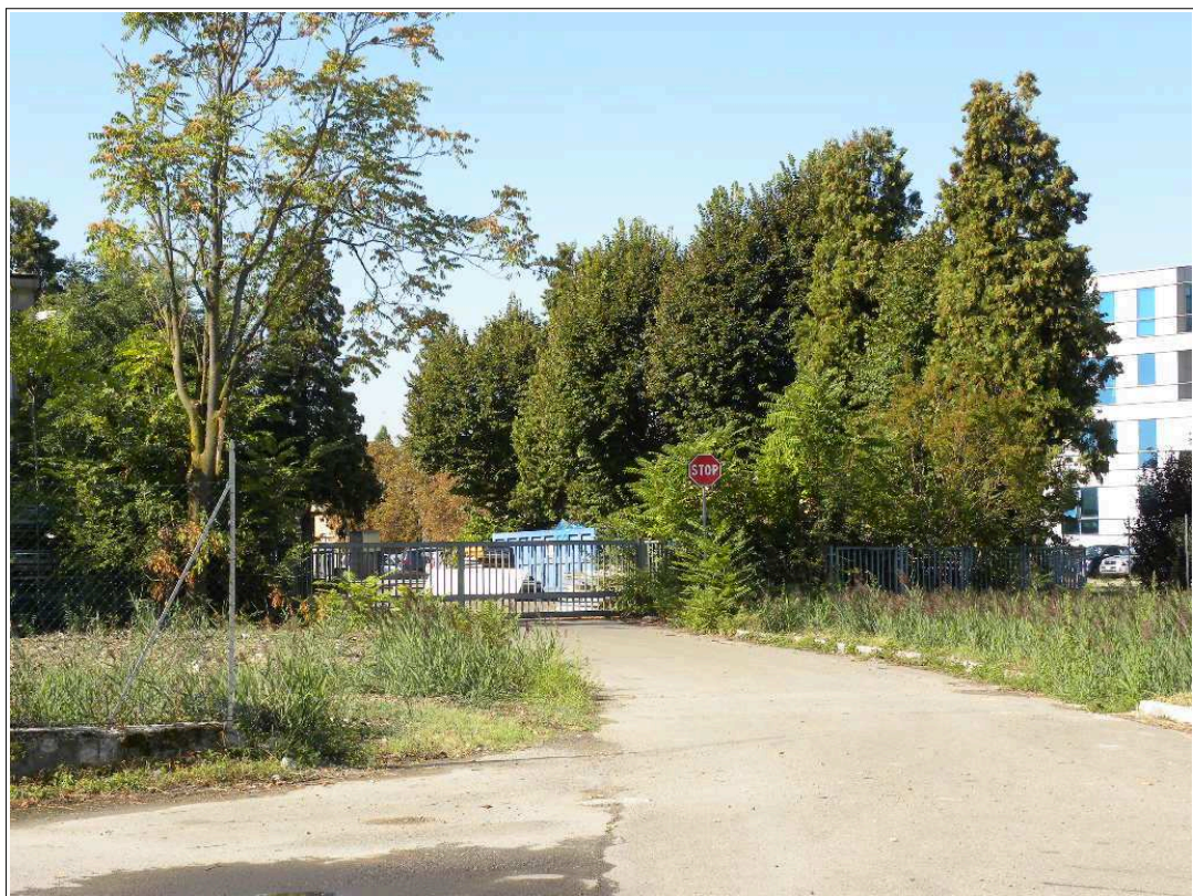
Particolare asfaltatura trasversale, all'altezza del mappale 164
