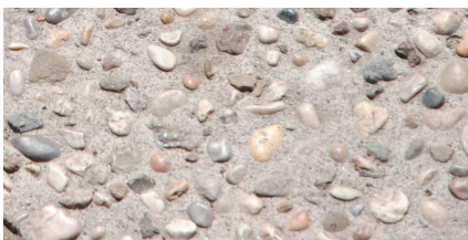
Dettaglio pavimentazione in Levocell
