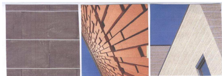
ESEMPI E RIFERIMENTI DI RIVESTIMENTI FACCIANISTA. FIGHE ORIZZONTALI NON STILATE E FIGHE VERTICALI STROCCATE O CON ANZIANI ACCESSORI PER ESPANDERE LA CORSA ORIZZONTALE DEI PARTENTI.
