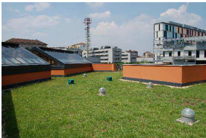
Figura 7. Esempio di tetto verde a Torino (fotografia tratta dal sito www.parcoartevivente.it/ )
