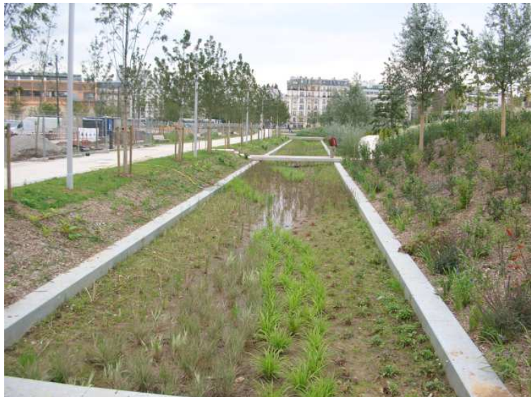
Figura 14.I canali infiltranti, in questo caso inverditi, se realizzati nello spazio pubblico, possono divenire elementi di riqualificazione legati anche alla fruizione e al tempo libero (foto: Parc Clichy, Parigi)
