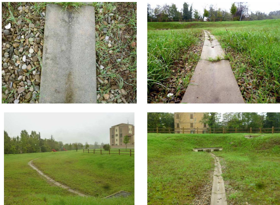
Figura 13. Vasca infiltrante recentemente realizzata a Canali (Reggio Emilia). Si noti la canaletta alla francese, realizzata con pendenza di circa 1%, impostata su un canale di infiltrazione a cielo aperto
