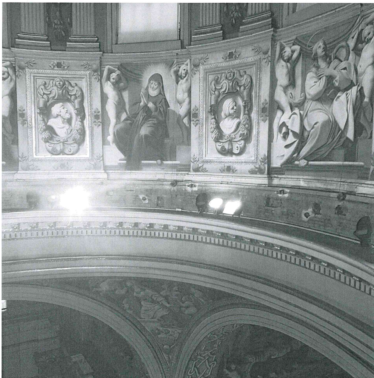
Attuale impianto di illuminazione
