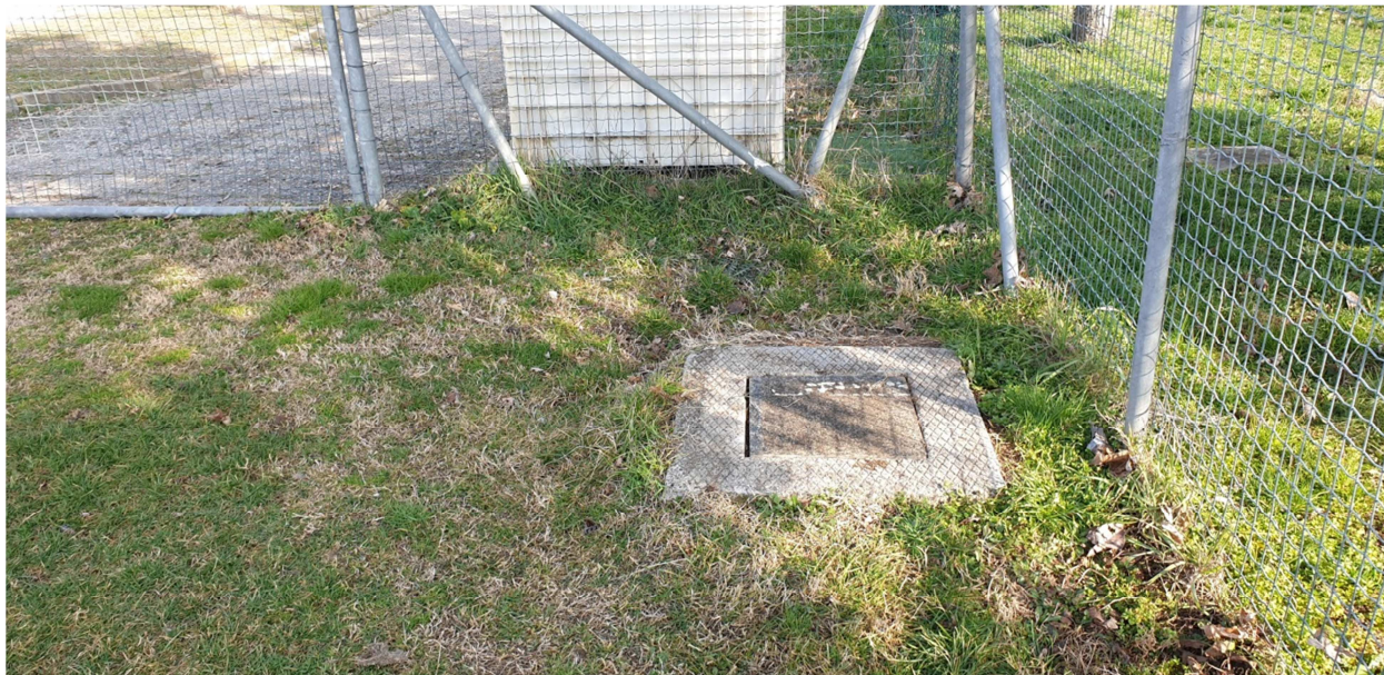
Pozzetto esistente di allaccio alla fognatura stradale
