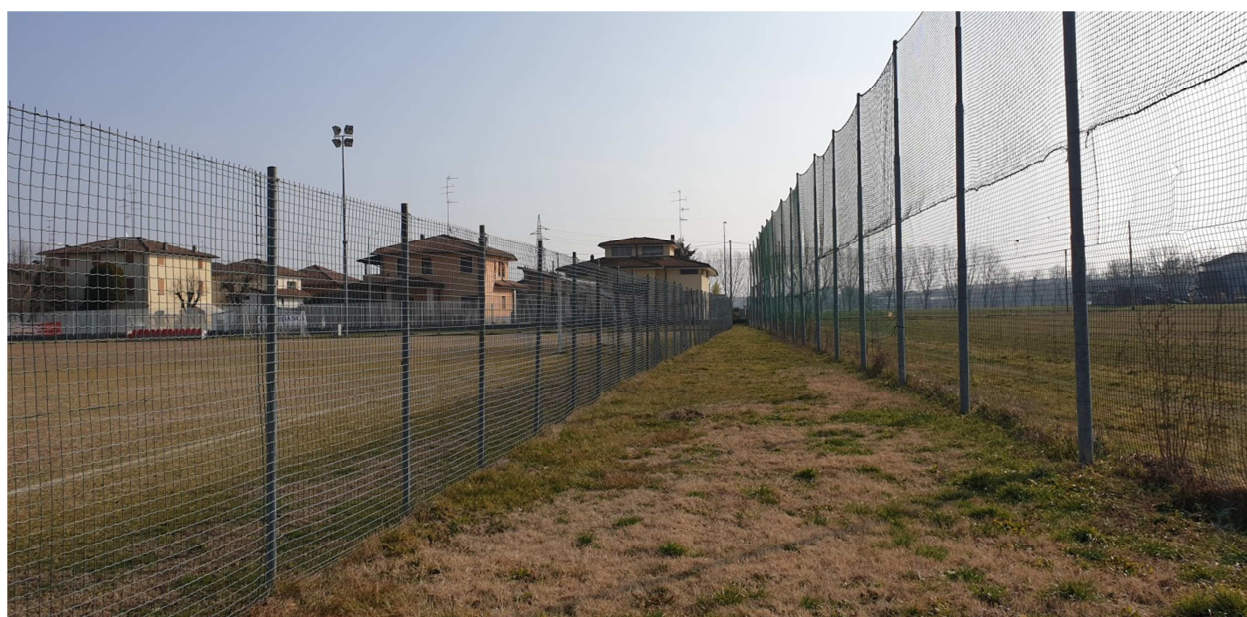
Area tra recinzione bassa intermedia e recinzione alta perimetrale su lato Sud
