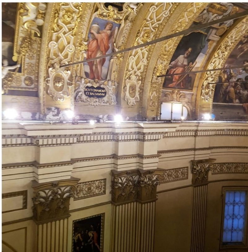
Attuale impianto di illuminazione
