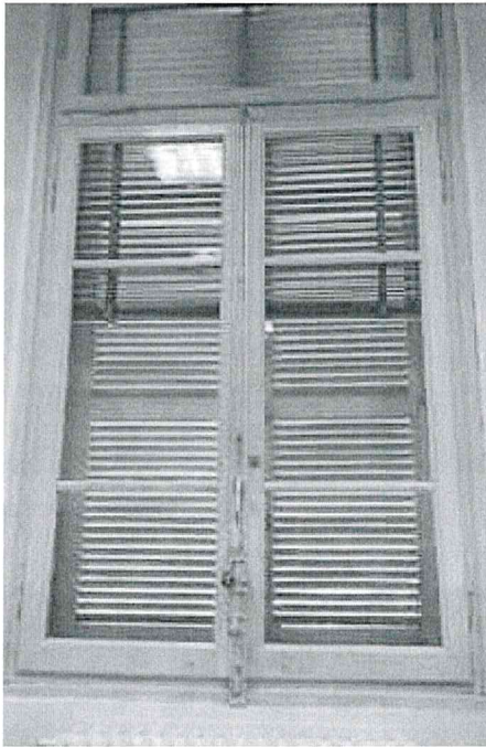
Foto 6 – serramento interno a due ante
