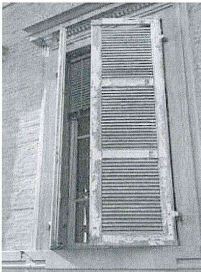
Foto 3 – particolare serramento a due ante
