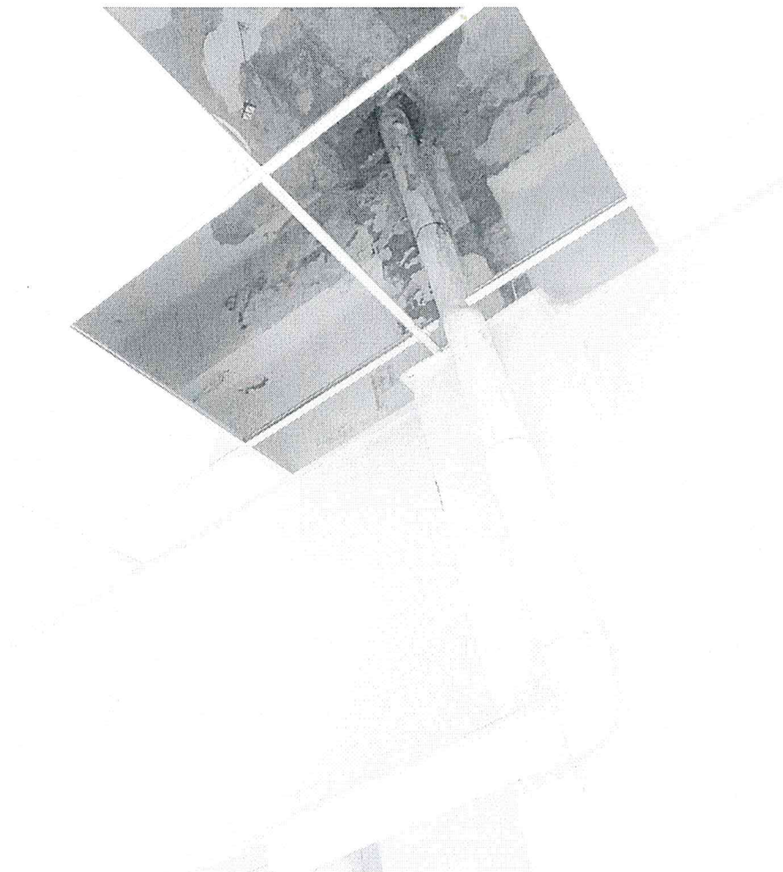
Figura 3: Pluviali interni da eliminare
