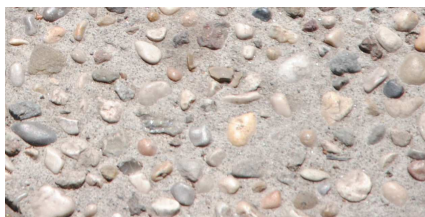
Dettaglio pavimentazione in Levocell
