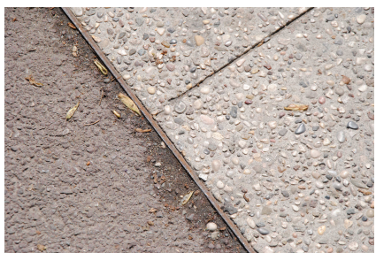
Dettaglio di cordolatura in ferro che segna lo stacco fra due tipi differenti di pavimentazione
