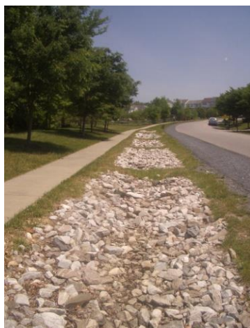
Figura 14. Esempio di canali infiltranti_ http://sustainablestormwater.org
