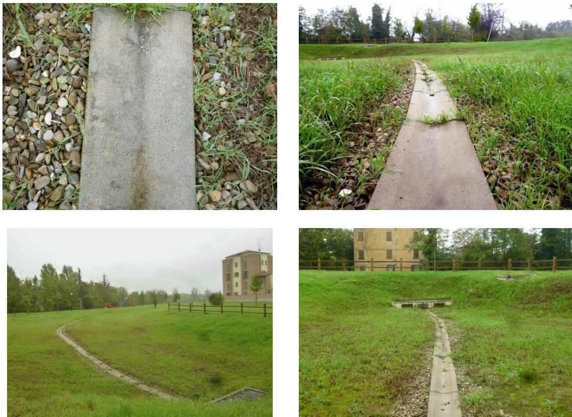
Figura 12. Invasi di piccole dimensioni in aree parcheggio (Figura tratta dal contributo “Come affrontare il rischio idraulico nella pianificazione urbanistica”, di A. Paoletti, http://www.csdu.it/CONVEGNI/2011/CREMONA/Cremona%2711_Paoletti-csdu-PoliMI_pres.pdf ).
