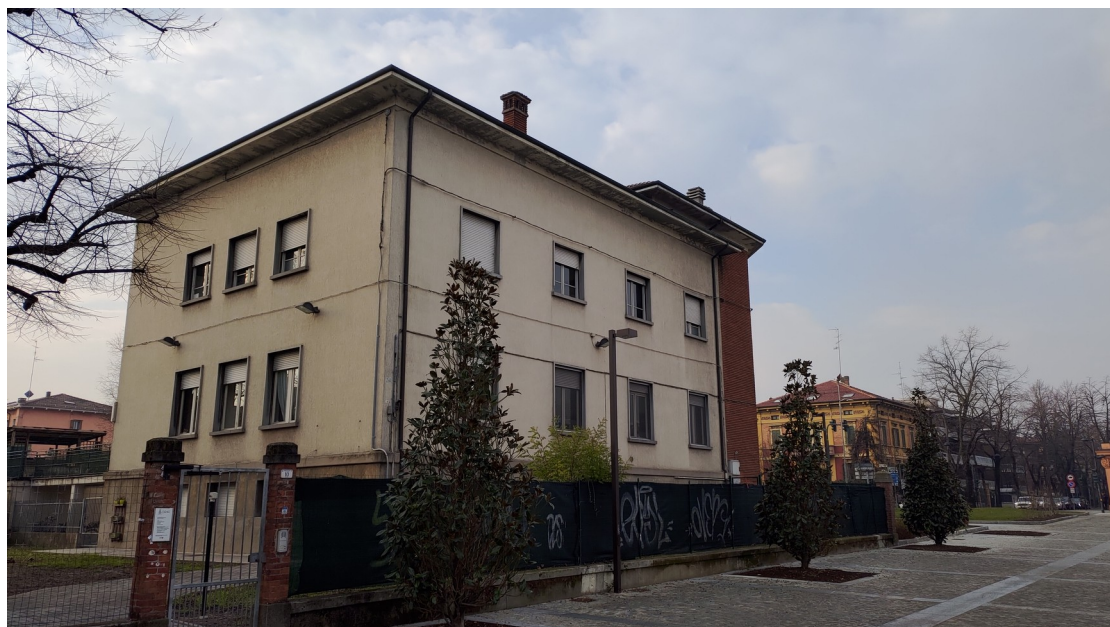
Vista esterna da via Guasco
