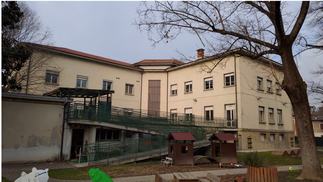
Vista cortile Interno con le rampe di collegamento con il giardino
