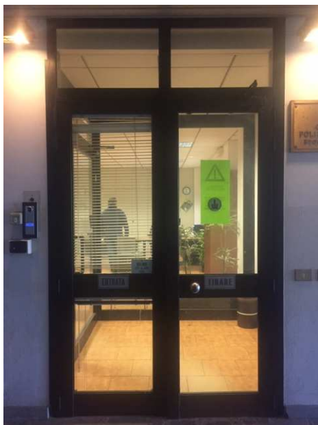
Porta vetri ingresso uffici primo piano
