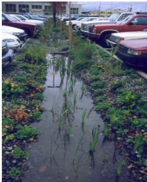
Figura 12. Invasi di piccole dimensioni in aree parcheggio (Figura tratta dal contributo "Come affrontare il rischio idraulico nella pianificazione urbanistica", di A. Paoletti, http://www.csdu.it/CONVEGNI/2011/CREMONA/Cremona%2711_Paoletti-csdu-PoliMI_pres.pdf ).
