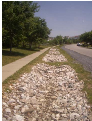
Figura 14. Esempio di canali infiltranti_ http://sustainablestormwater.org
