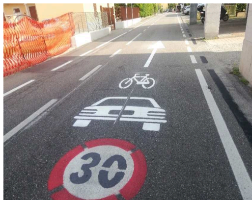
Esempio di segnaletica comportamentale dedicata
