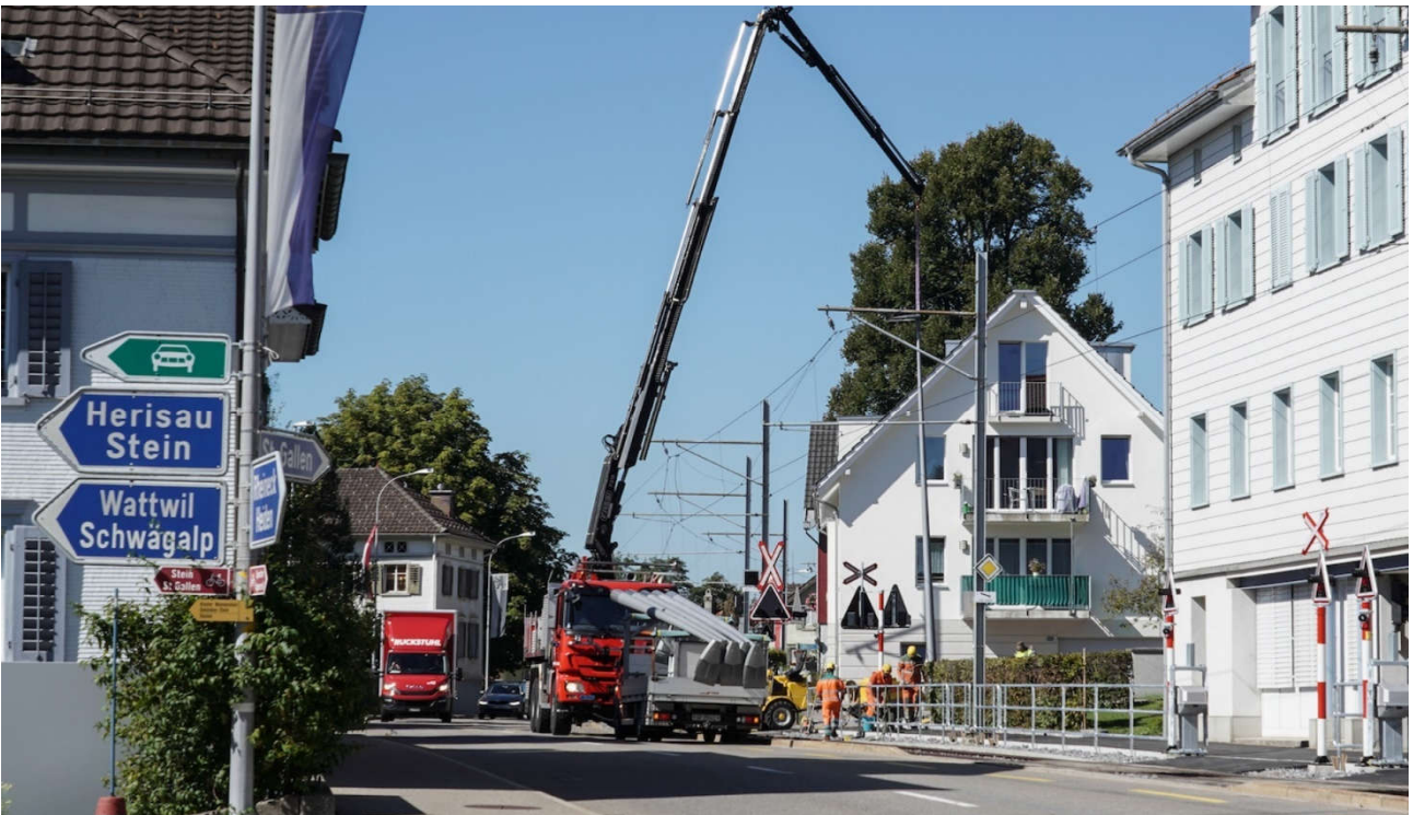
Fig. 23 – Teufen: lavori di installazione dei sostegni della linea di contatto
