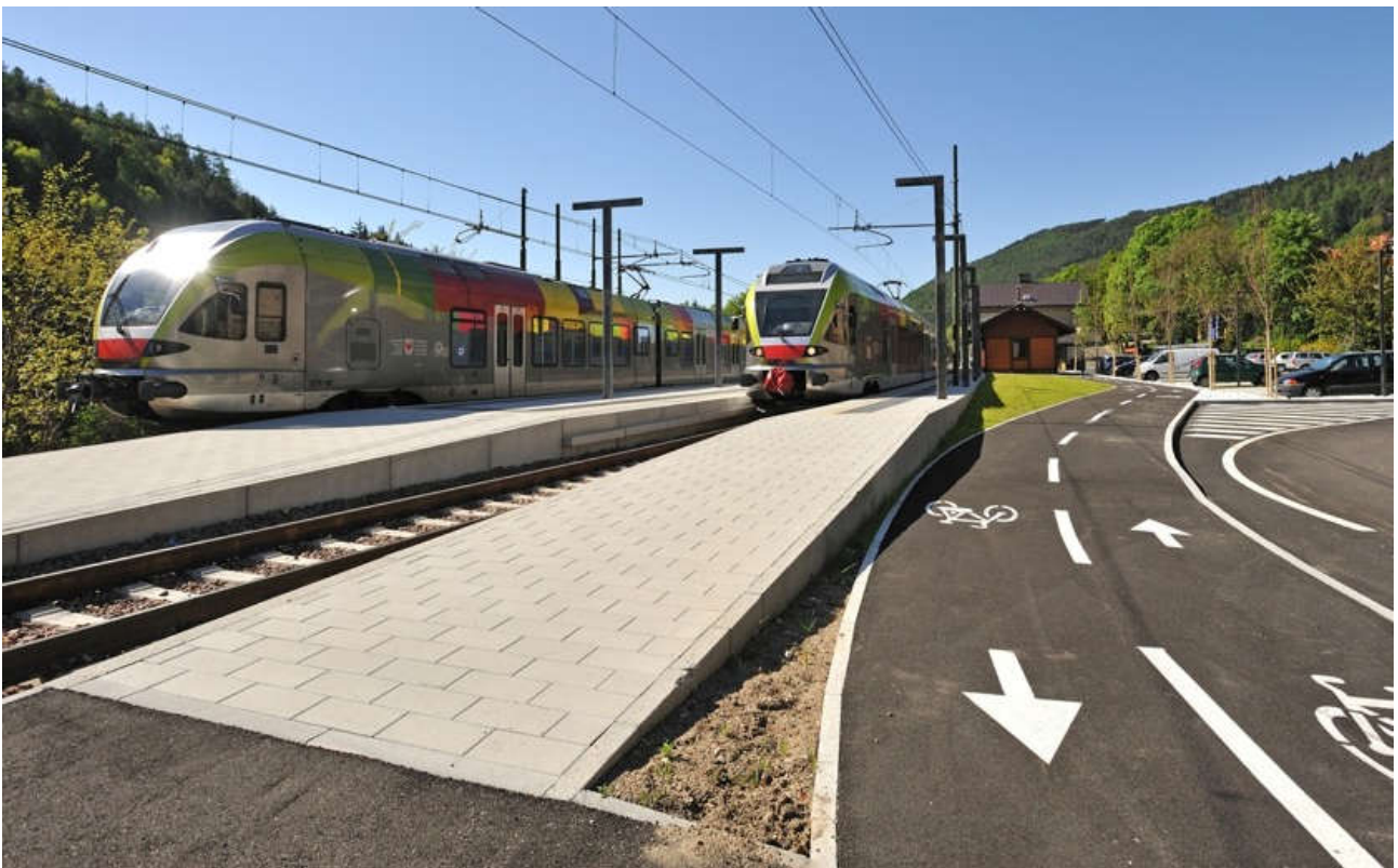
Fig. 28 – Linea della Val Venosta: esempio di fermata ferroviaria trasformata in un efficace nodo di scambio multimodale. Si noti l'assenza di barriere tra la banchina ferroviaria e l'esterno
