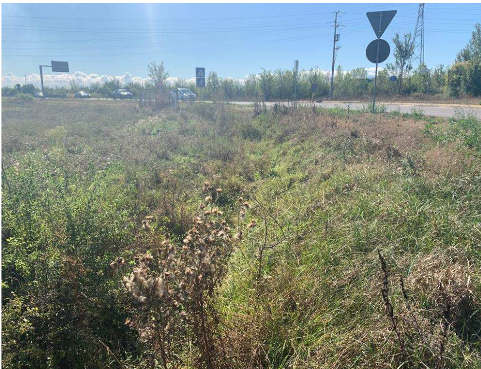
Fosso di guardia lungo SP113 non oggetto di risagomatura
