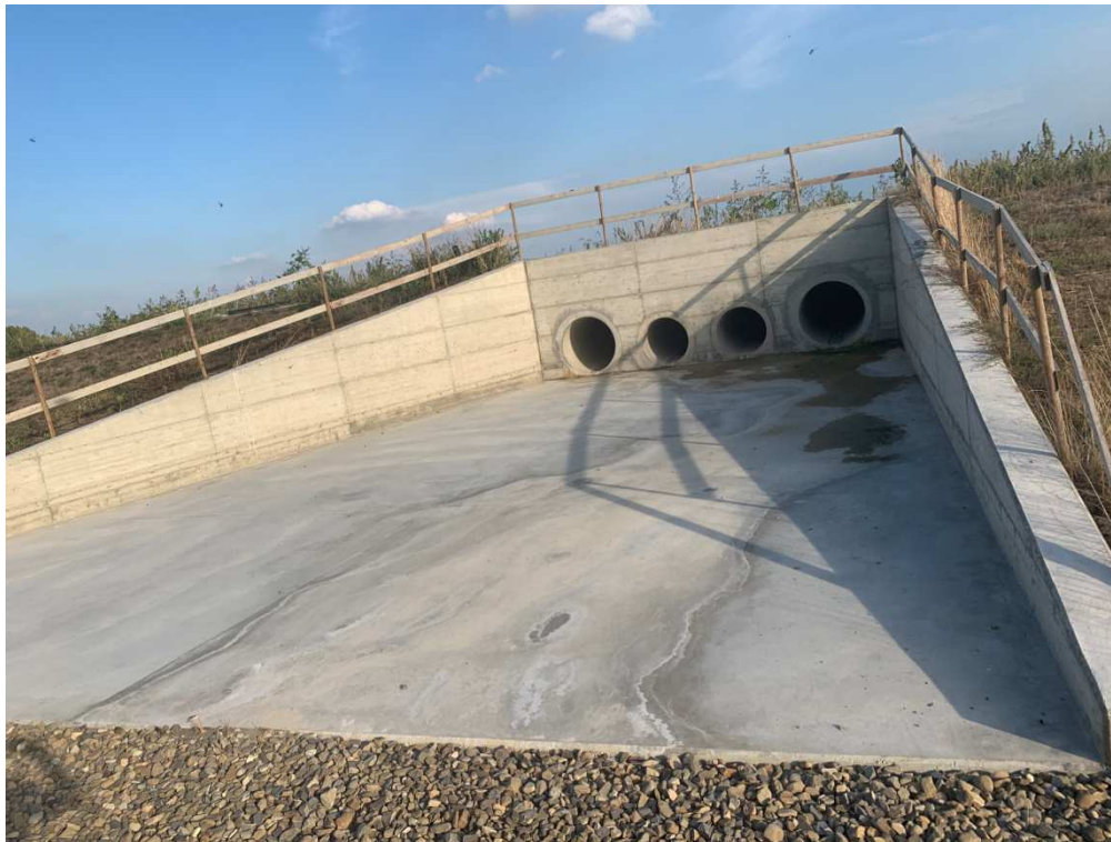
Manufatto in c.a. di scarico DA MANTENERE
