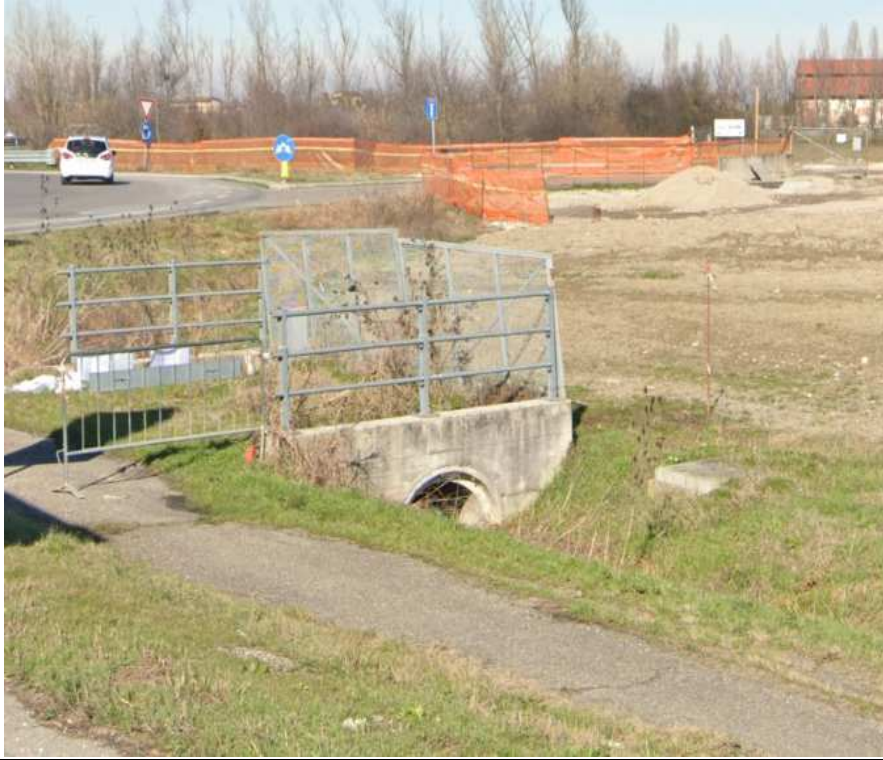
Manufatto in c.a. lungo SP113 – inizio risagomatura fosso di guardia verso monte
