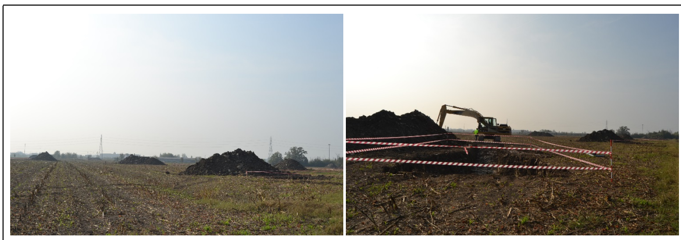
Area di intervento a fine lavori
