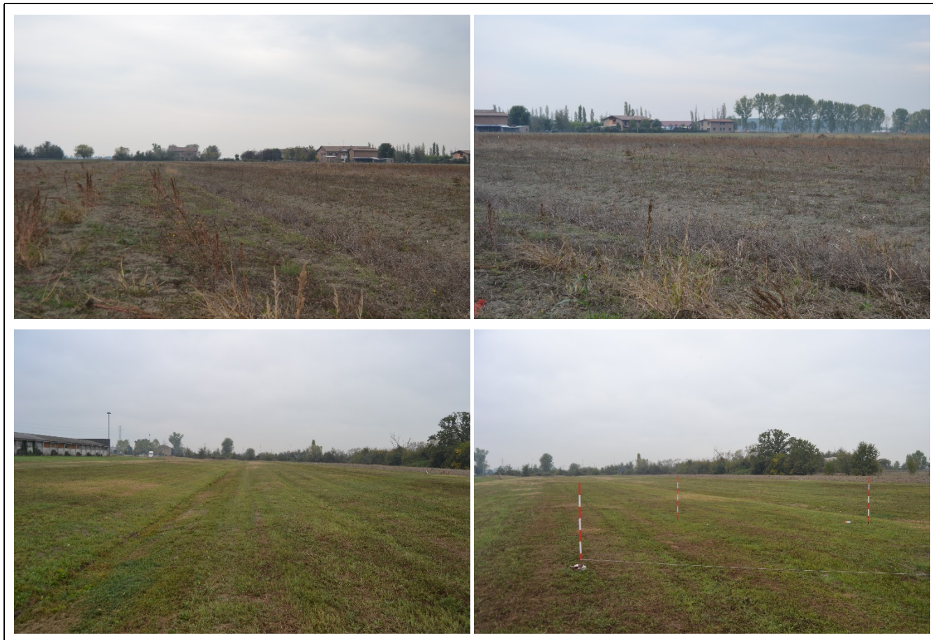
Area di intervento a inizio lavori
