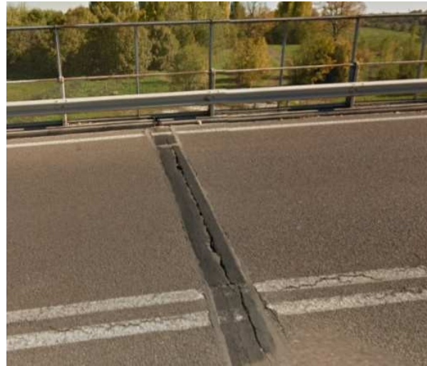
Fig. 1.6.1- Alcuni giunti su cordolo che devono essere sistemati per impedire il percolamento
