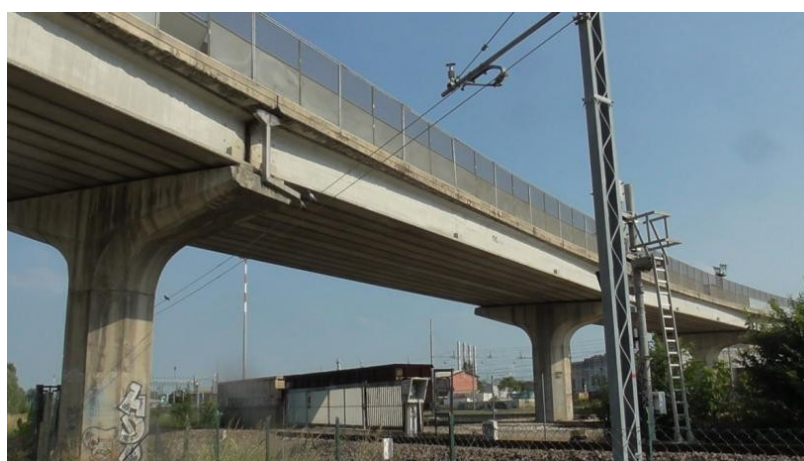
Fig. 1.2-Viste dell'impalcato dalla sede stradale sottostante
