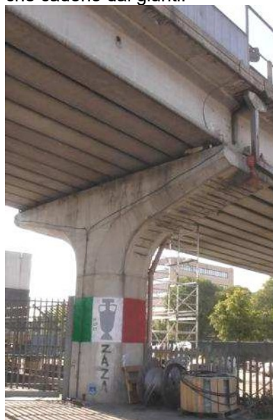
PILA3 da sud lato ovest
