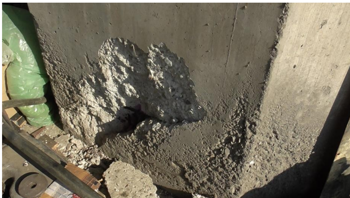
PILA3: alla base il copriferro di 5cm è facilmente rimovibile e non si ottiene viraggio
