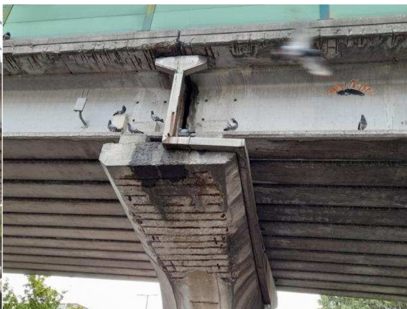
PILA2 da sud lato ovest
