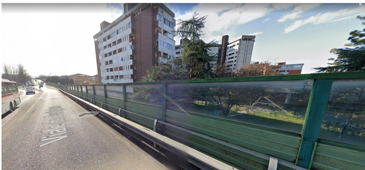
antirumore presenti sul lato di via Turri
