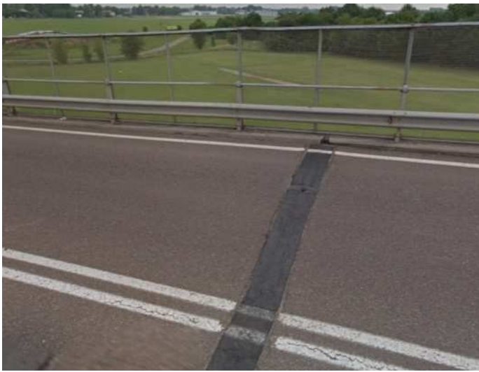
Fig. 1.6.1- Alcuni giunti su cordolo che devono essere sistemati per impedire il percolamento
