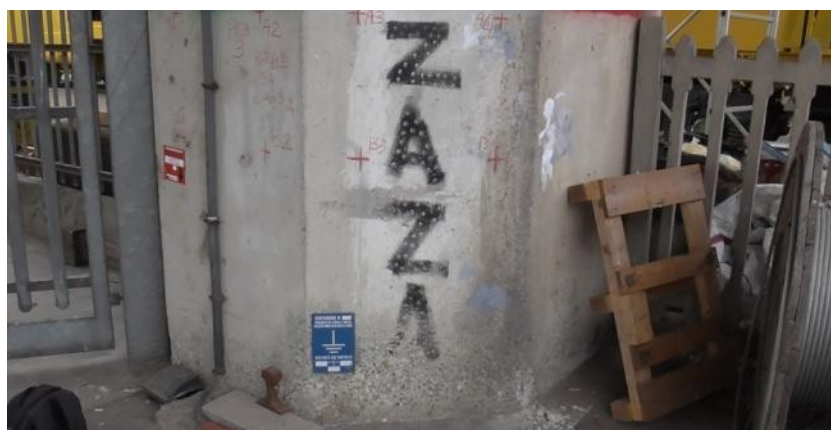
Fig. 1.4.2-Griglia di percorsi ultrasonici sulla pila3
