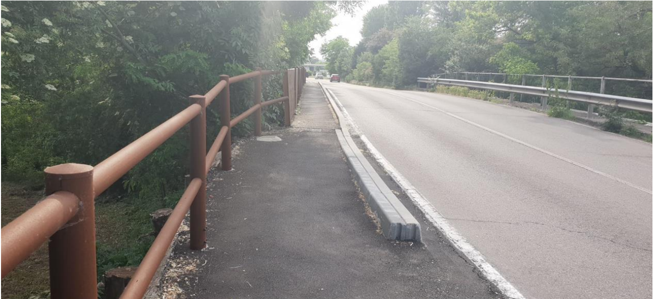
Foto n.1: Restringimento improvviso pista ciclabile con totale assenza di illuminazione
