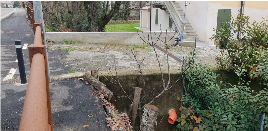
Foto n.1: Cedimento del terrapieno di contenimento altezza n. 33 ancora non riparato nonostante la presenza del cantiere
