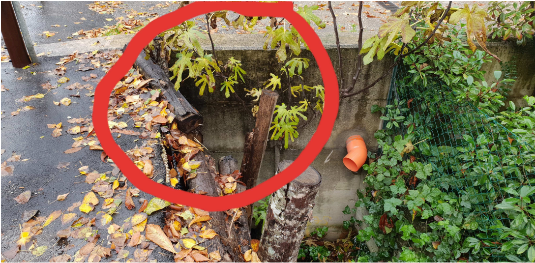
Foto n.1: Cedimento del terrapieno di contenimento altezza n. 33 ancora non riparato nonostante la presenza del cantiere
