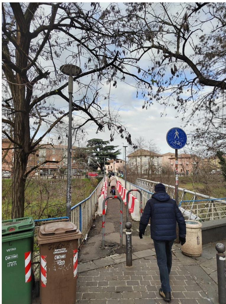
Passerella ciclopedonale Quartiere Gattaglio, foto del 27 Gennaio 2023
