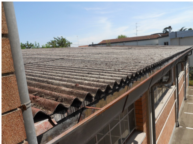
Vista della copertura in lastre di cemento amianto
