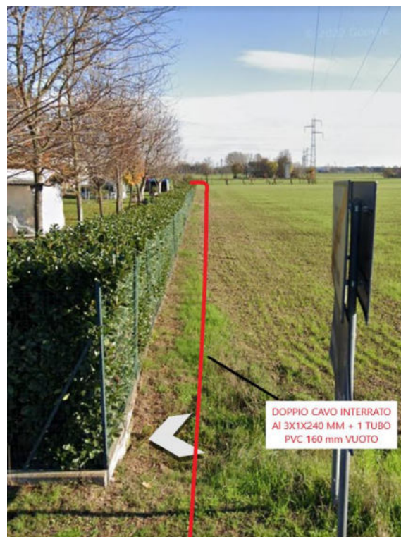
Foto 3: Linea interrata in terreno agricolo
