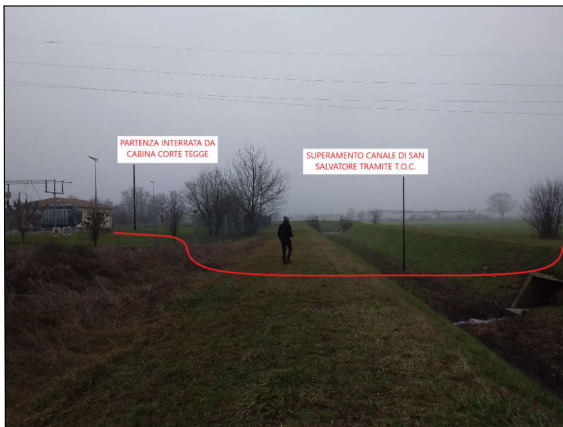
Foto 1: Linea interrata in uscita dalla Cabina Primaria di CORTE TEGGE ed attraversamento Canale di San Salvatore con T.O.C.
