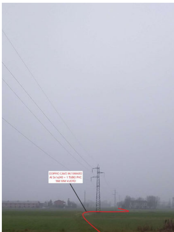
Foto 2: Linea interrata in terreno agricolo
