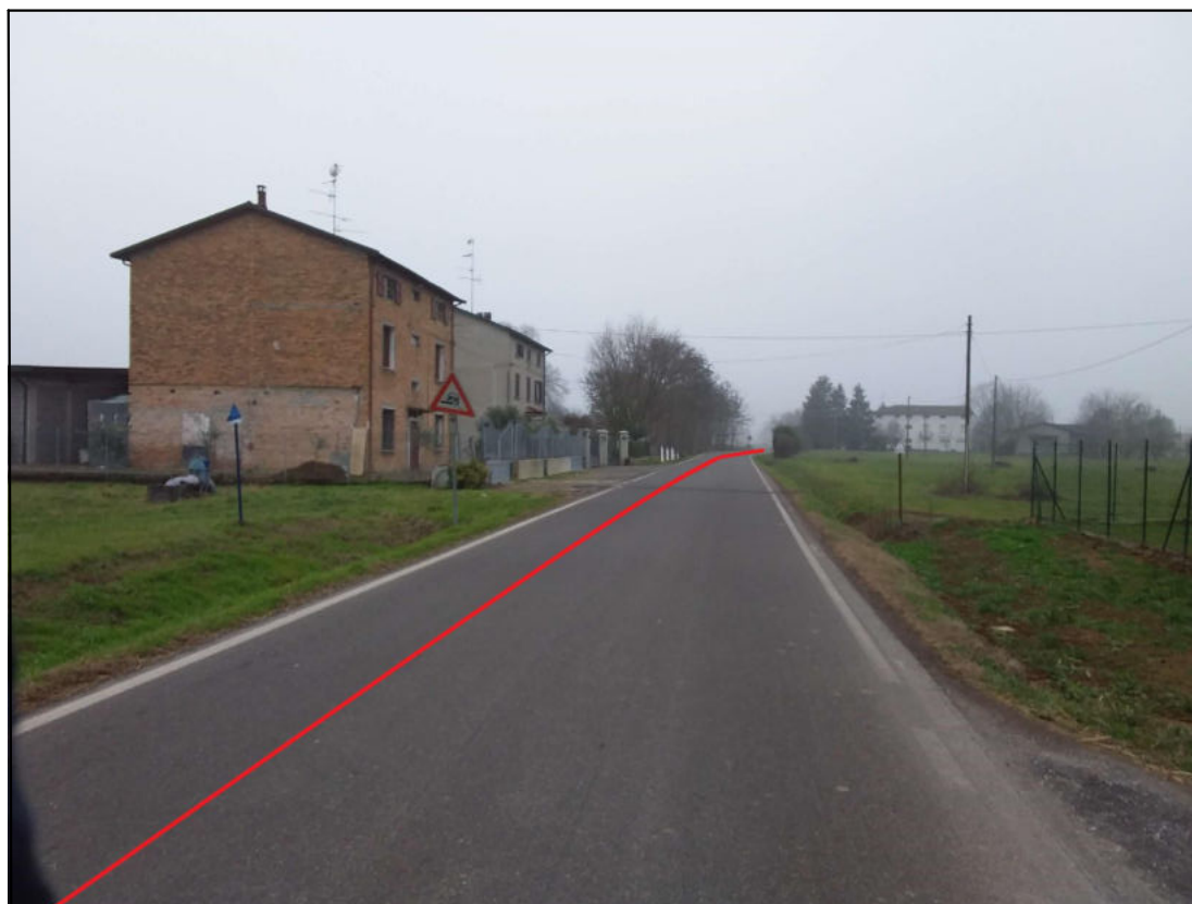
Foto 6: Nuova linea interrata MT in percorrenza di via Bassetta
