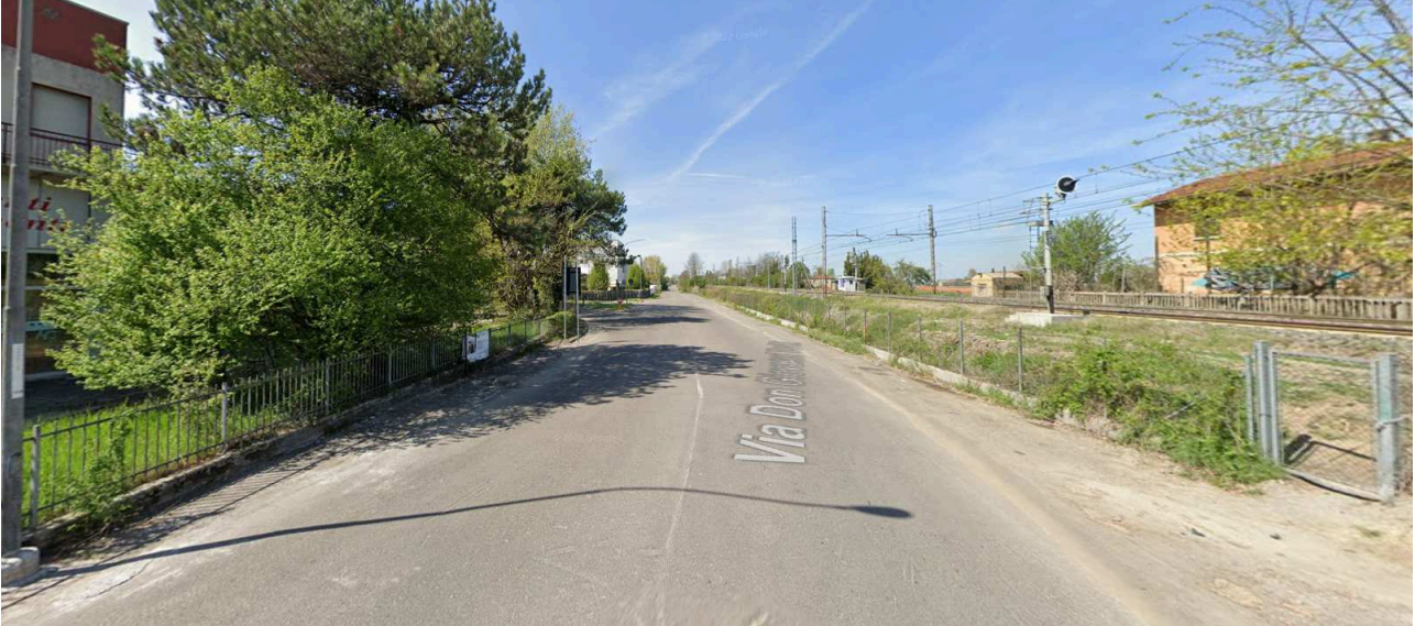
Via Don G. Verità - tratto compreso tra il Torrente Crostolo e Via Agnoletti
