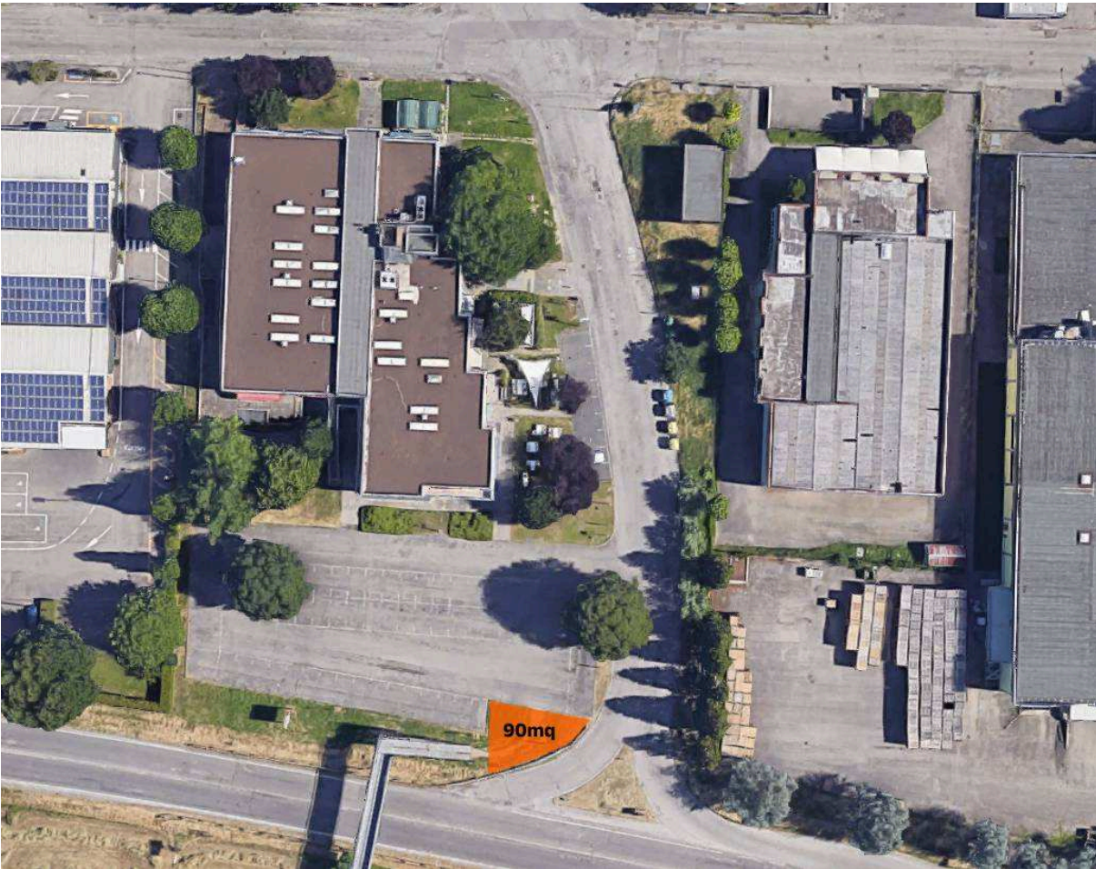
Area di cantiere stralcio B
