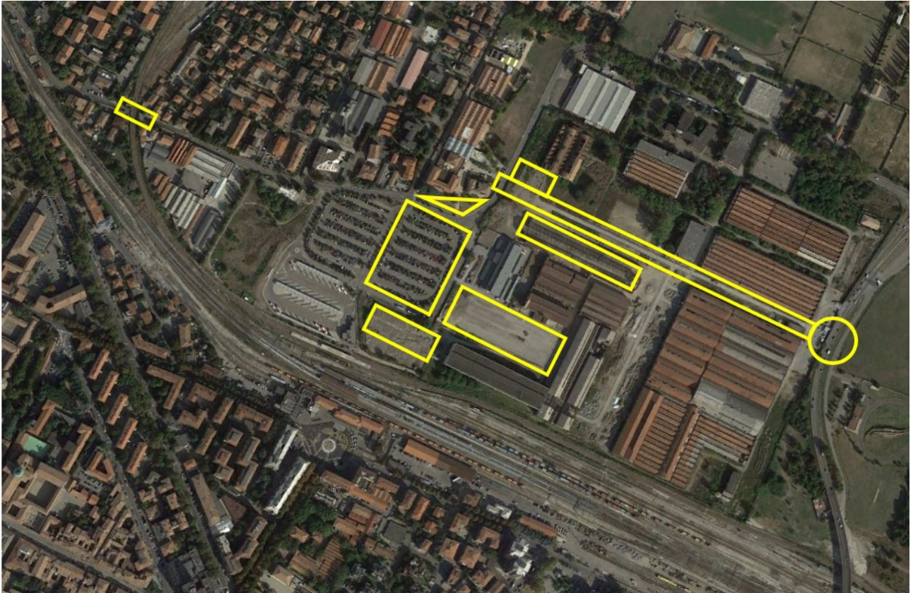
Assetto del comparto nel 2016 (immagine estratta da Google Earth) con evidenziate le aree e i fabbricati oggetto di intervento negli ultimi anni
