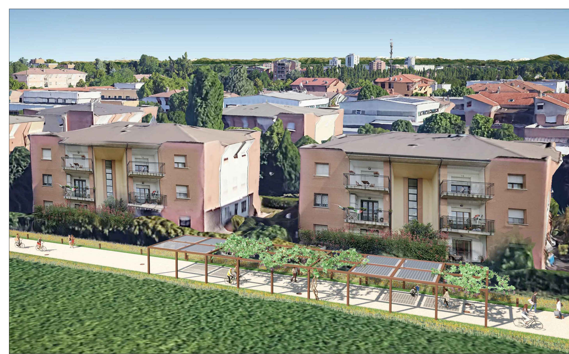
Pergola di protezione del percorso. Pista ciclabile e percorso pedonale separati. Copertura alternata in parte in vite rampicante in parte con pannelli fotovoltaici.
