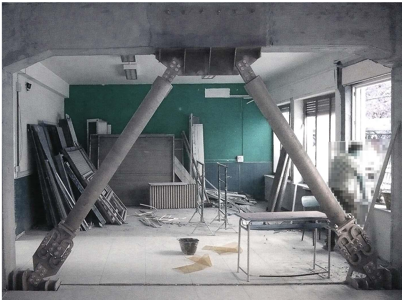
Installazione di controventi dissipativi
