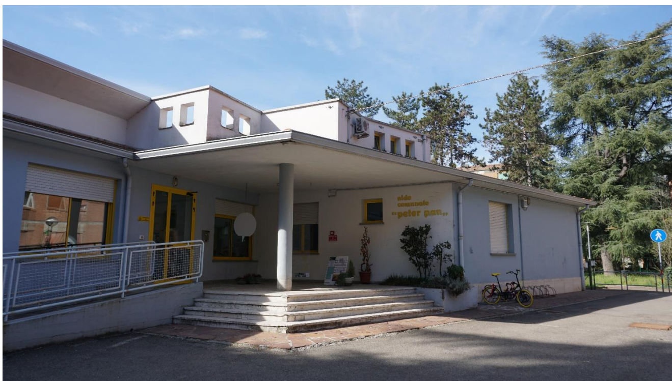
Figura 1 - Fotografia dello stato attuale dell'edificio
