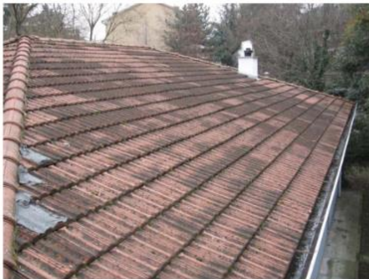
Fig. 1 – Vista aerea copertura a capanna
