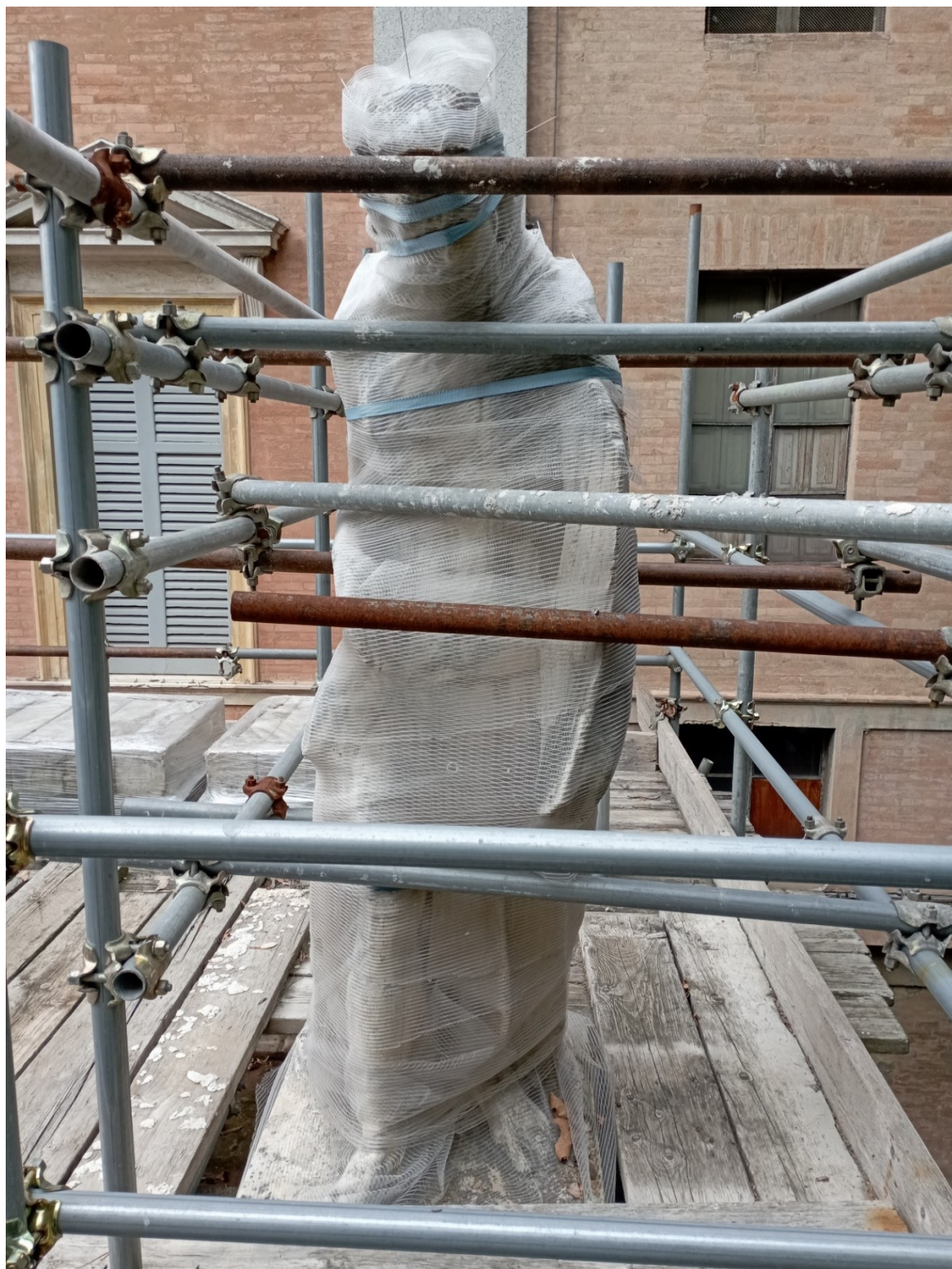
Dedalo: foto complessiva con i presidi di sicurezza
