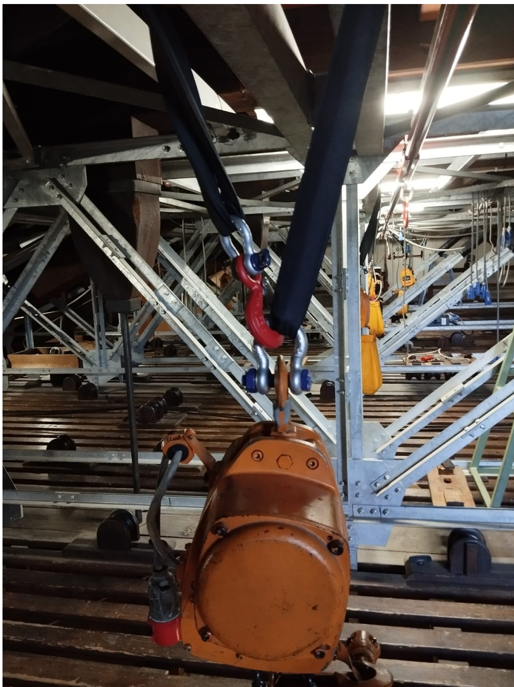
Attuali motori applicati alle strutture della graticcia
