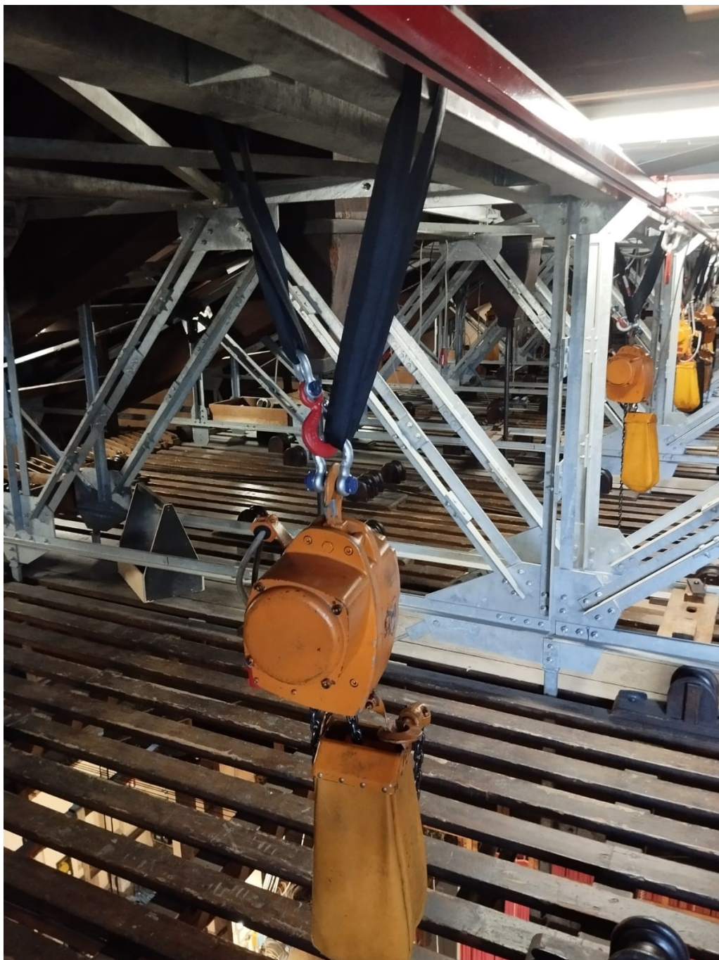
Attuali motori applicati alle strutture della graticcia
