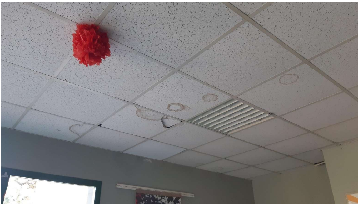
Rifacimento del controsoffitto e delle luci zona sala principale piano terra
