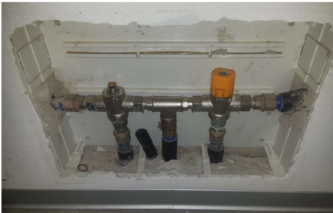
Modifica collettore per collegamento ACS zona Bar
