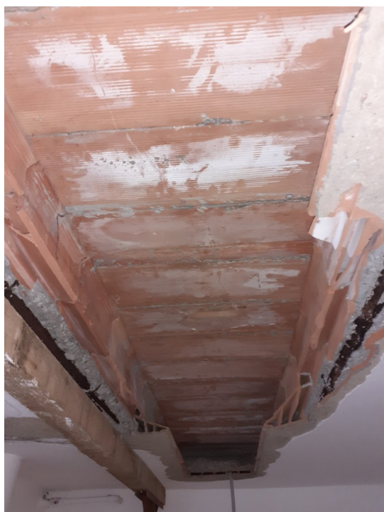
Foto n. 1 – zona servizi igienici al piano seminterrato
