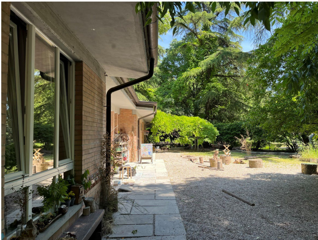
Lo stato dei luoghi. Il fronte sul quale verrà realizzata la nuova aula-bioclimatica.
