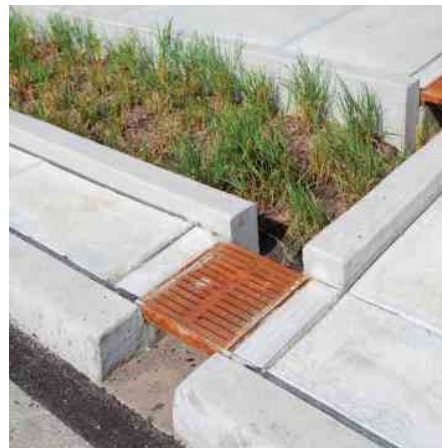
Fig. 9. Esempio pozzetto di sedimentazione (schema e fotografia)
