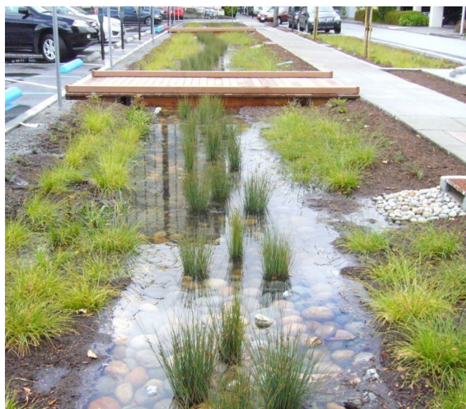
Fig. 8. Esempio fascia inerbita per il trattamento in rain garden con ingresso dell'acqua diffuso
