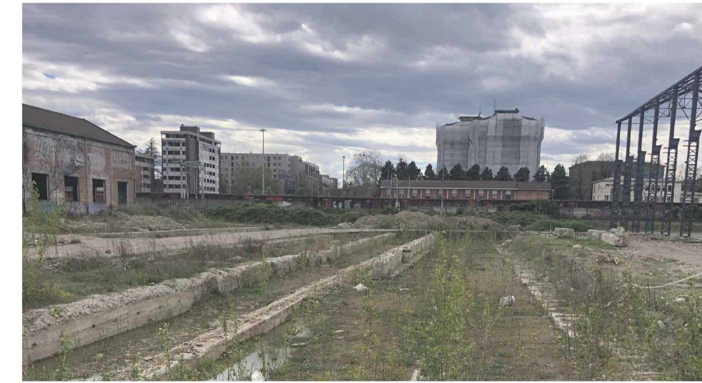
documentazione fotografica dello stato dei luoghi
