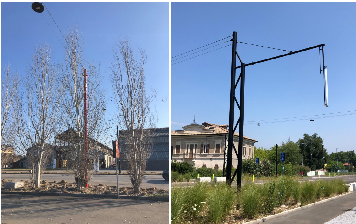
Figura 18 – Foto del sistema a tesate già realizzato in viale Ramazzini e Piazzale Europa.
