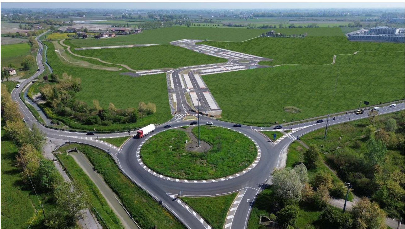
Vista aerea con opere urbanizzazione completate
