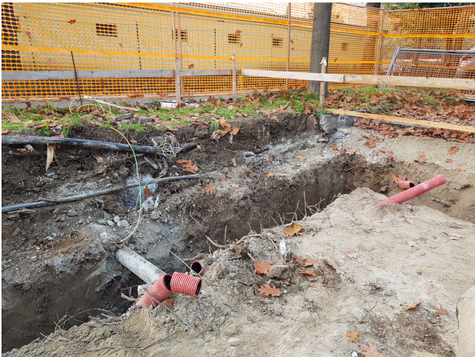
rinvenimenti impiantistici al di sotto della struttura del foyer-biglietteria.
