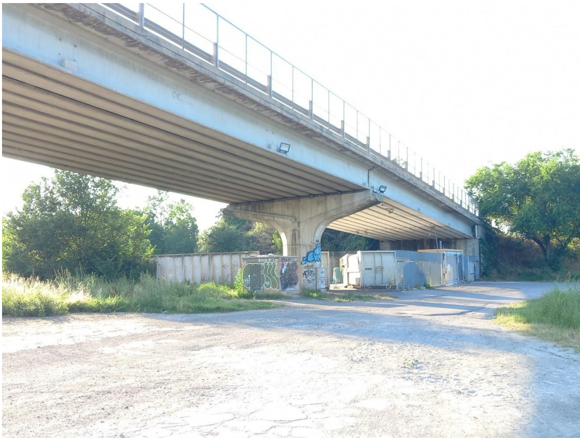
Figura 6 – Foto dell'ingresso da via Marro verso l'isola ecologica
