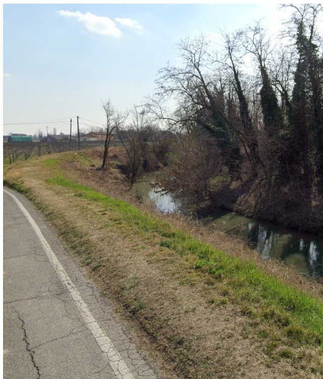
Figura 15: Vista lato torrente in direzione Est
