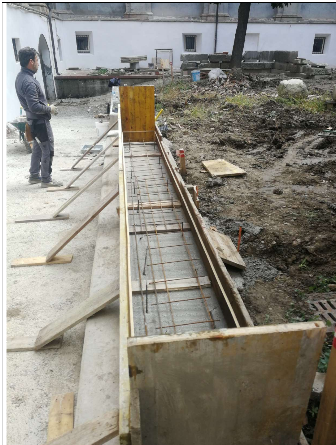
Lato Nord _Realizzazione basamenti per ricollocazione reperti
