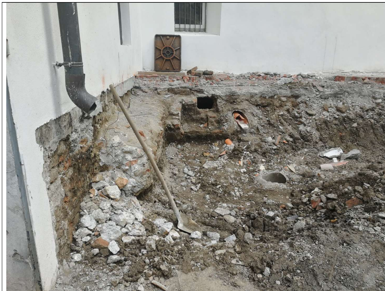
Angolo NE, scavi e rinvenimenti di manufatti e impianti
