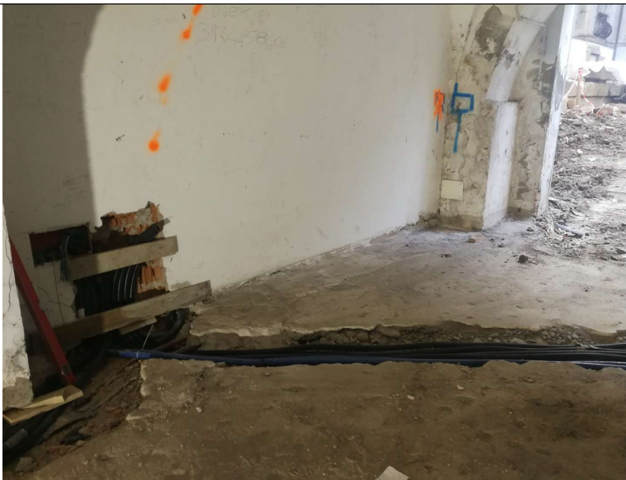
Galleria di passaggio – predisposizioni impiantistiche
