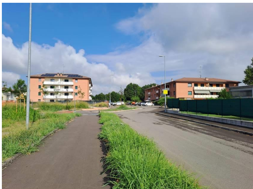
Vista da ingresso Via degli Azzarri
