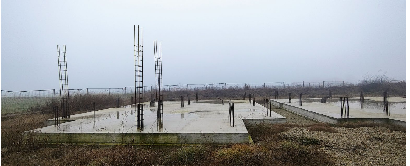
Platea di fondazione, ferri di chiamata e armature pilastri fabbricato "3"
