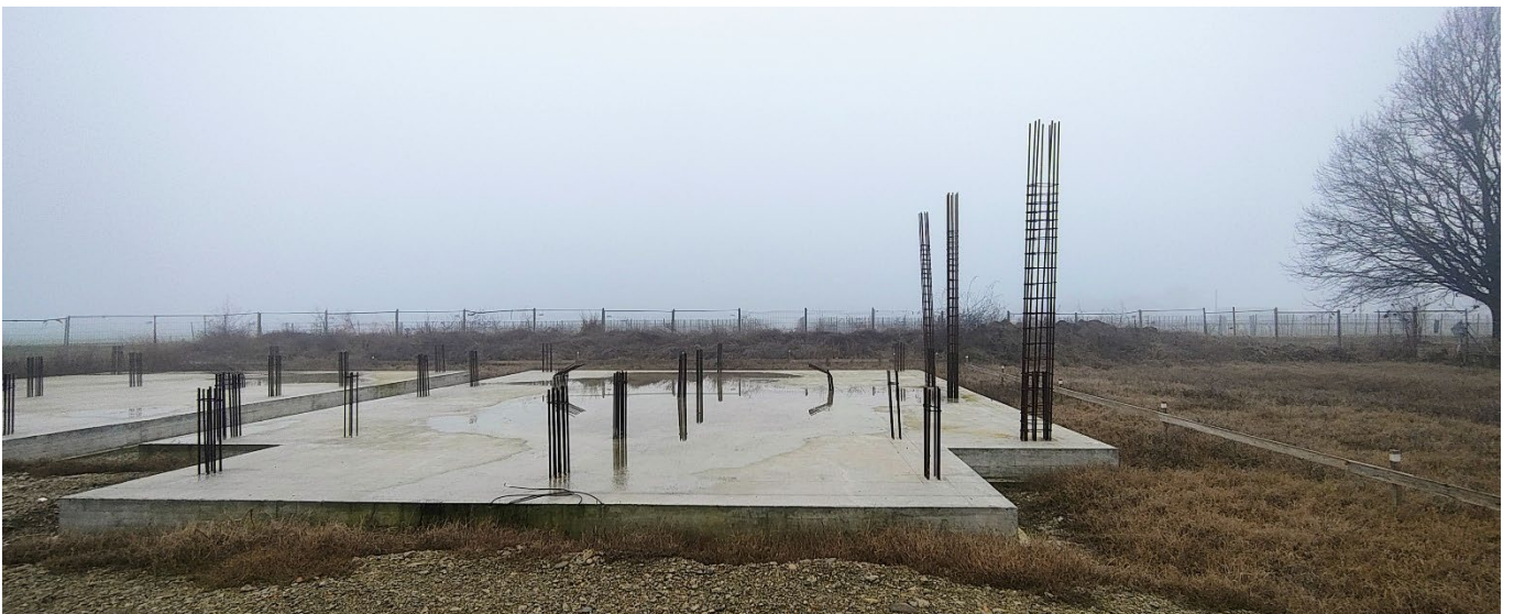
Platea di fondazione, ferri di chiamata e armature pilastri fabbricato "4"
