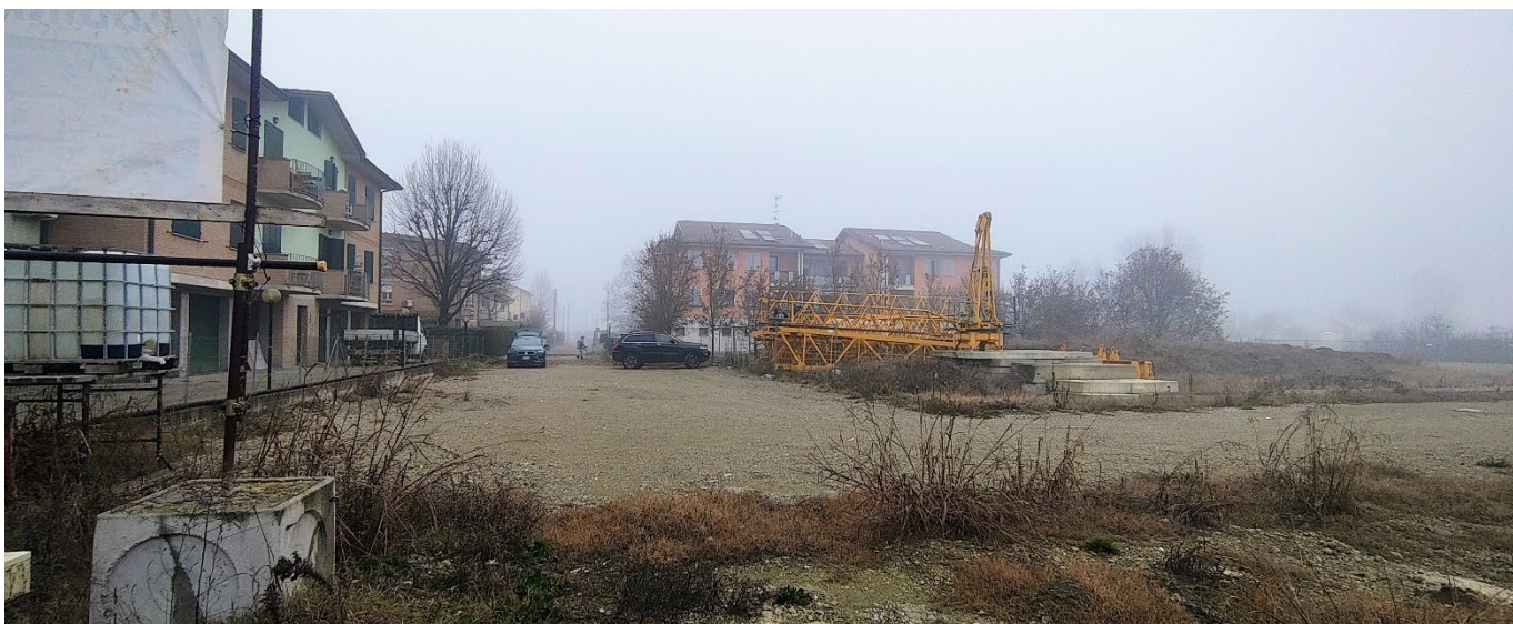
Massicciata ingresso lottizzazione e area parcheggi ad uso pubblico
