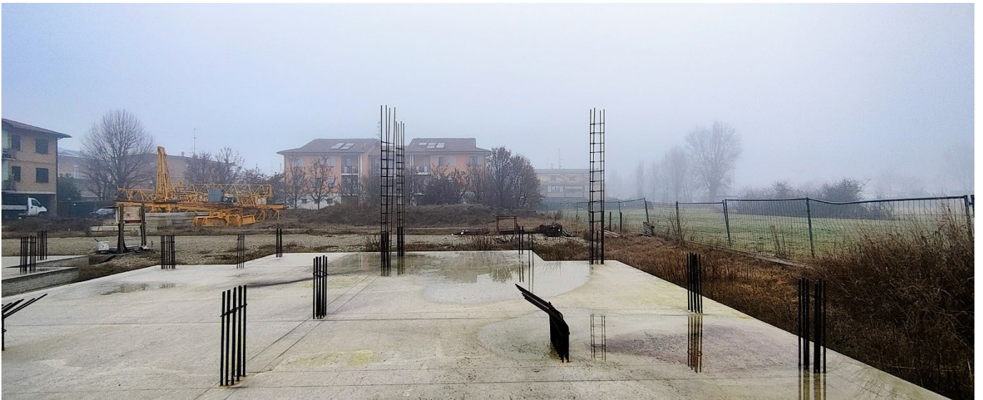
Particolare platea di fondazione, ferri di chiamata e armature pilastri
