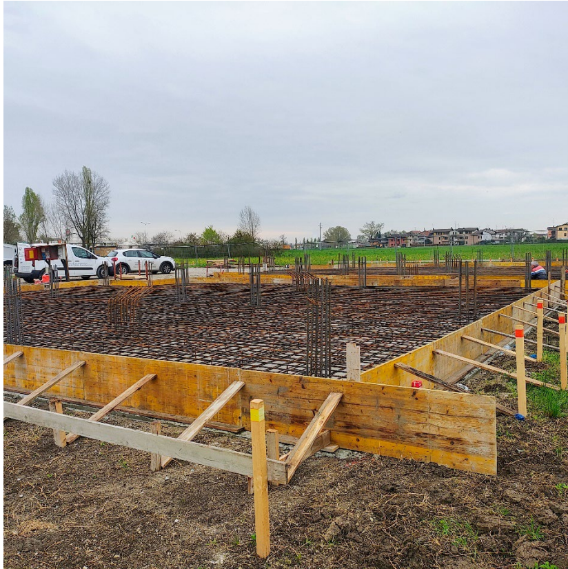
Armatura platea di fondazione
