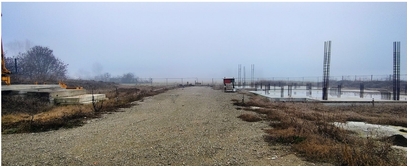
Massicciata strada di penetrazione e transennamento lato orientale del lotto
